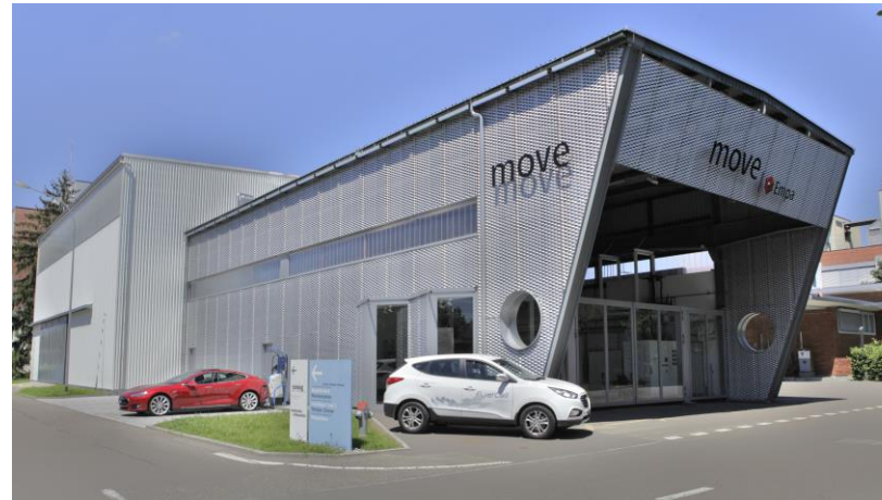
Standort Erlebnisstation Autofahren bei der Versuchsanlage «move».
